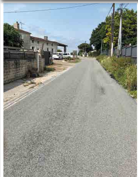
Juin 2023 : Les travaux de la rue du quereux
