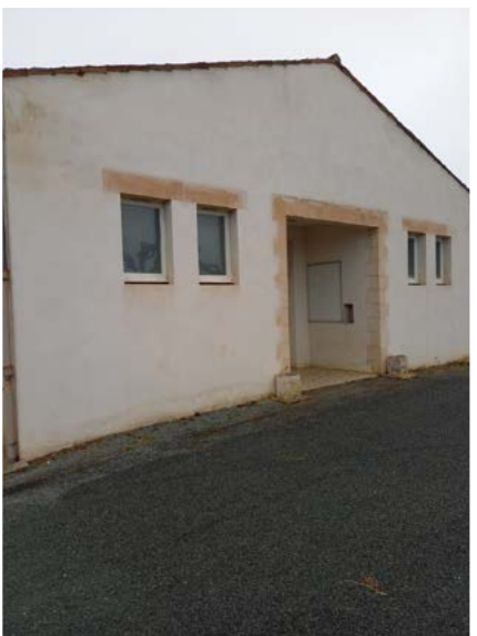
Fév 2021: Nettoyage des façades de la salle des fêtes
