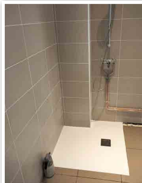
Création d'une douche au multiservices
