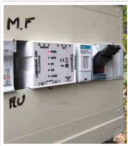
Réglage des commandes d'éclairage public
